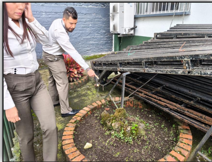
Valoración de riesgo por parte del COPASST de un auto reporte realizado por un colaborador sobre las condiciones inseguras de estos soportes de carpas.
